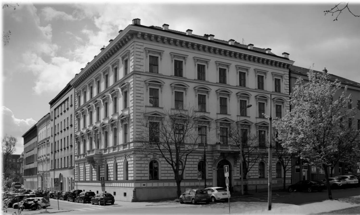
Sídlo Nejvyššího státního zastupitelství v Jezuitské ulici v Brně
